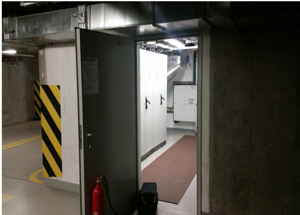
Rozdzielnia w parkingu podziemnym - brak sygnału
